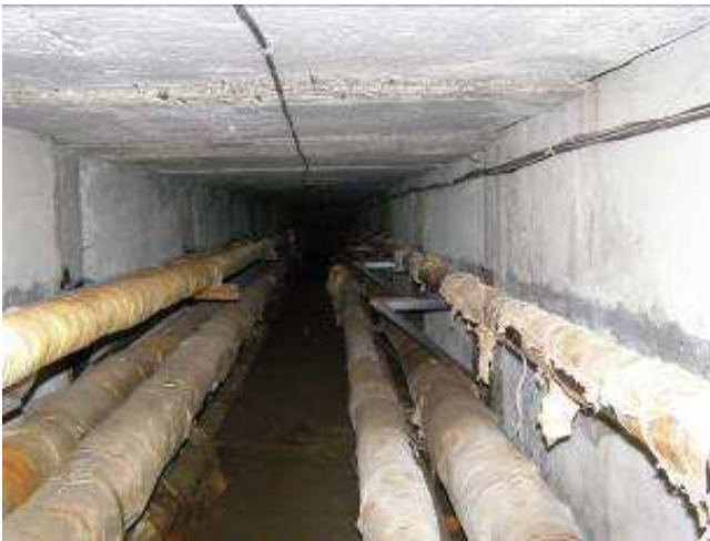
Проходной канал для размещения коммуникаций
